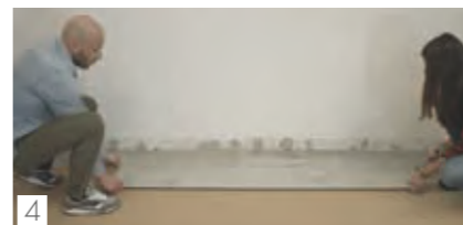
4 Posare il pavimento senza fuga Lay the floor tiles whit close joints
