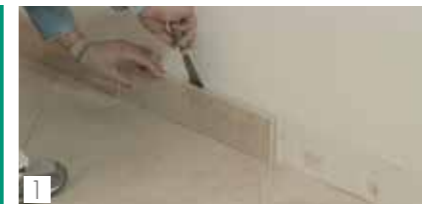
1 Eliminare il battiscopa Remove skirting
