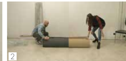
2 Stendere il tappetino Lay the underlayer
